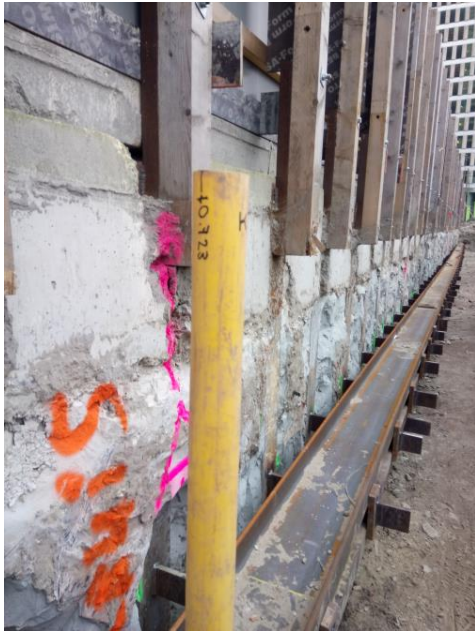
Foto 5 Peilbuis in de bouwkuip
