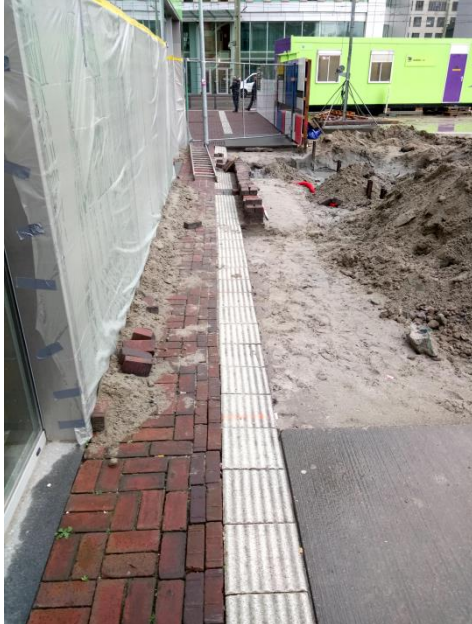
Foto 9 Verwijderen van looppad
