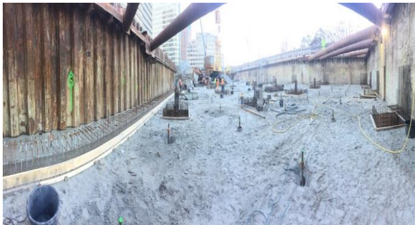
Foto 6 Ontgraven van de bouwkuip
