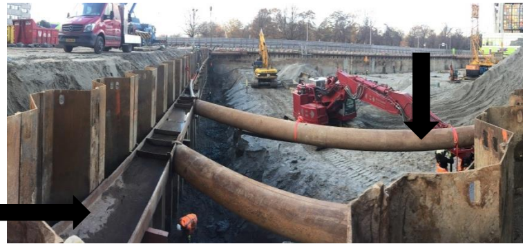
Foto 7 Gordingen (pijl links) en stempelraam (pijl rechts) in de hoek Rijnstraat/Bezuidenhoutseweg
