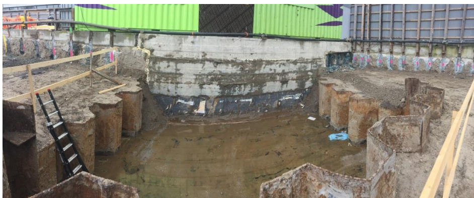
Foto 1. Huidige situatie van de New Babylontunnel
